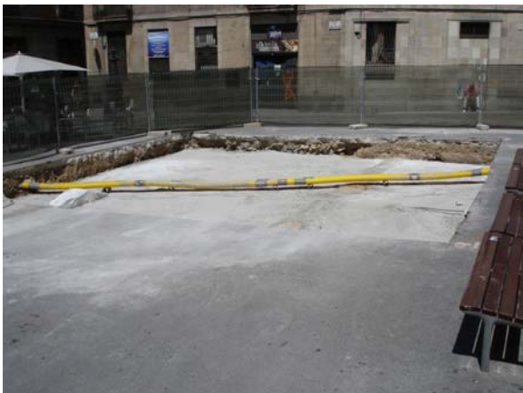
Vista general final des de l'est de la cala una vegada reomplerta amb formigó.
