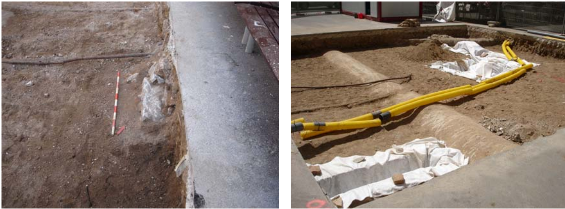
Vista des del sud del mur u.e. 1021 (esquerra) i vista general del sondeig des del nord una vegada protegides les estructures amb geotèxtil.
